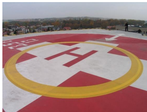
Lądowisko nad Pawilonem M- V – powstało w wyniku realizacji projektu „Zintegrowane Centrum Specjalistycznej Medycyny Ratunkowej”.
