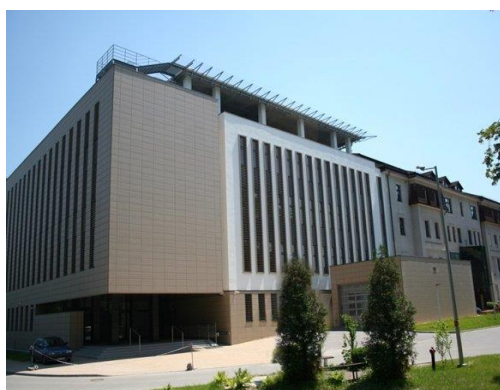
Widok Pawilonu M - V od strony północno - zachodniej - wejście D
