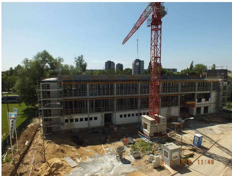
Plac budowy Małopolskiego Centrum Leczenia i Rehabilitacji Oparzeń oraz Chirurgii Plastycznej i Replantacyjnej wraz z Oddziałem Intensywnej opieki medycznej dla Dzieci
